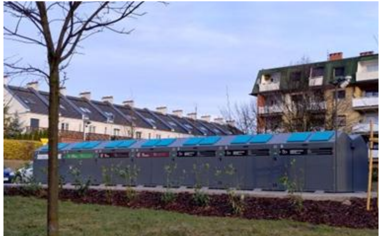
System Indywidualnej Segregacji Odpadów przy ul. Kopernika 21D w Śremie (jedna z sześciu lokalizacji)
