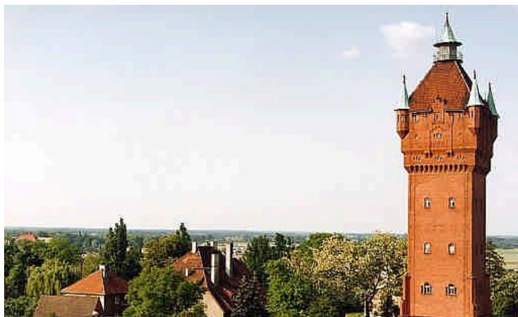
13. Wieża ciśnień przy ul. Mickiewicza
