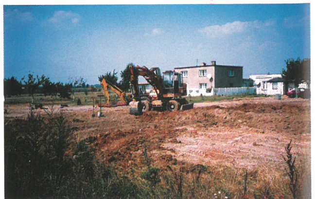
Budowa kanalizacji sanitarnej w Szymanowie
