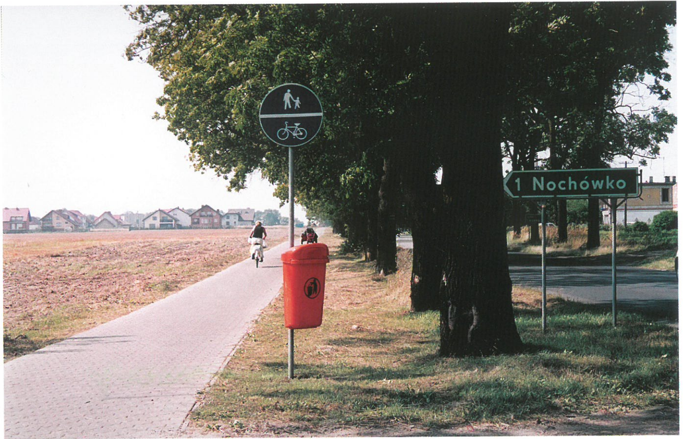
Chodnik i ścieżka rowerowa na odcinku Śrem - Nochowo
