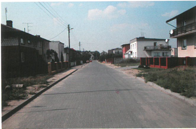
Nowo wybudowana ulica na osiedlu domków jednorodzinnych w Psarskiem
