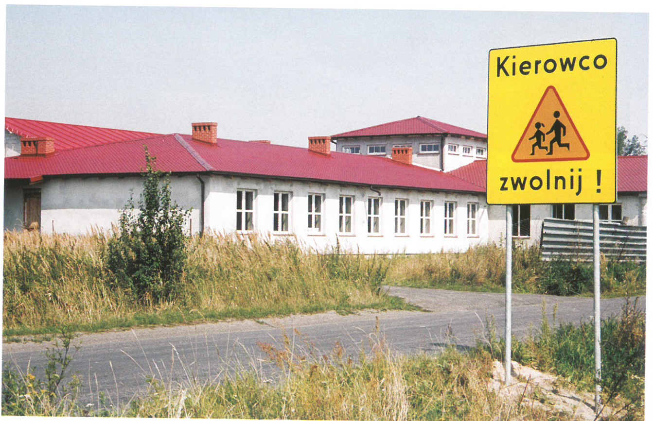
Budynek szkoły gimnazjalnej w Dąbrowie - w budowie
