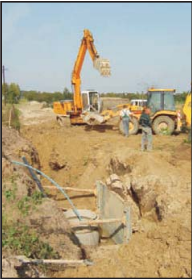
60. Budowa kanalizacji sanitarnej w Psarskich (ul. Sikorskiego) - 2006 r.
