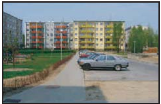
24. Nowe parkingi przy ulicy Grunwaldzkiej w Śremie wybudowane w 2005 i 2006r.
