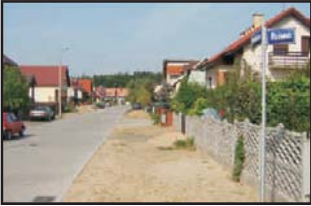
27. Nowo wybudowana ul. Jaśminowa w Psarskich - 2006r.
