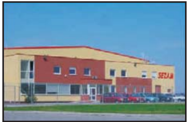
52. Hurtownia SEZAM w Zbrudzewie uruchomiona w 2005 r.
