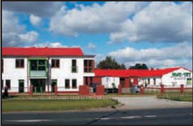
45. Nowe obiekty hurtowni MULTIVET przy ul. Staszica oddane do użytku w 2004 r.
