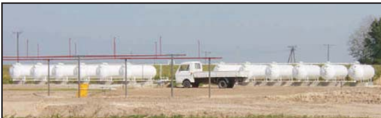
57. Nowo wybudowany magazyn paliw płynnych firmy BUT GAZ w Śremskim Parku Inwestycyjnym 2006r.
