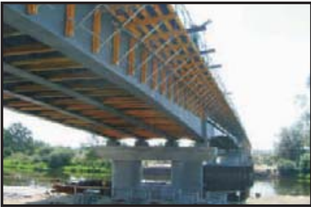
1. Budowa mostu na Warcie w przebiegu obwodnicy - sierpień 2006 r.
