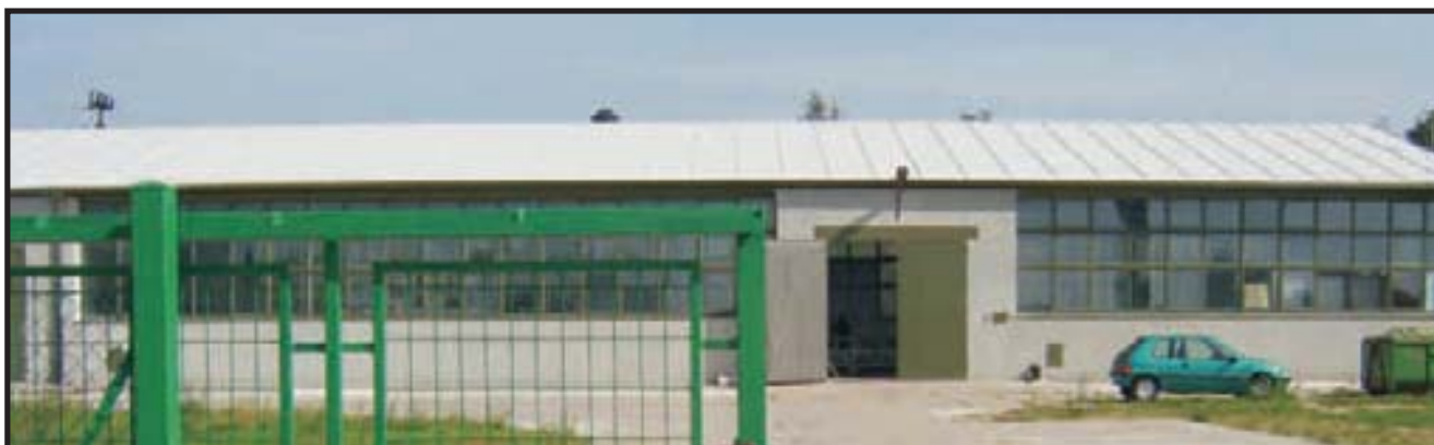
58. Zaadaptowana do celów produkcyjnych przez firmę REHAU hala przy ul. Wiosennej, obok ŚPI 2006r.
