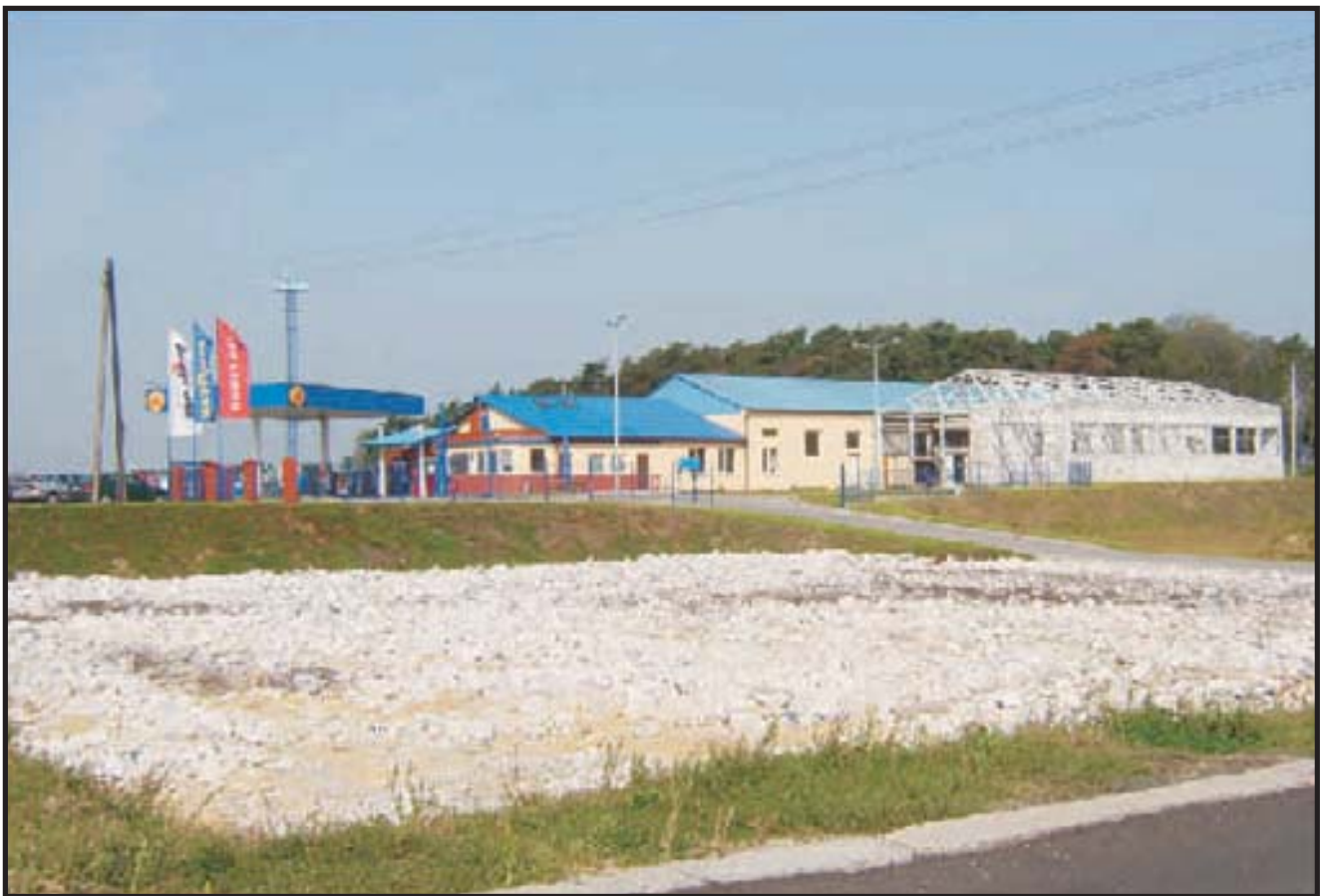
54. Rozbudowa firmy WĘGLOSTAL w Szymanowie 2006r.
