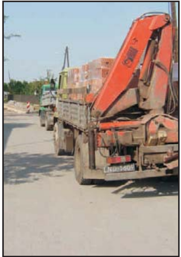
61. Budowa drogi gminnej w Szymanowie - 2005 r.
