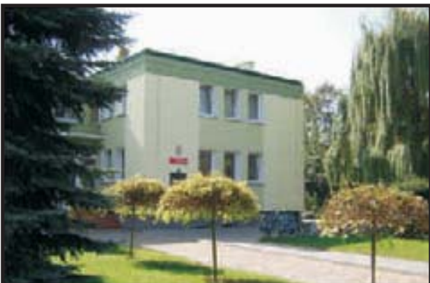
7. Budynek Szkoły Podstawowej w Bodziewie po termomodernizacji - 2005r.
