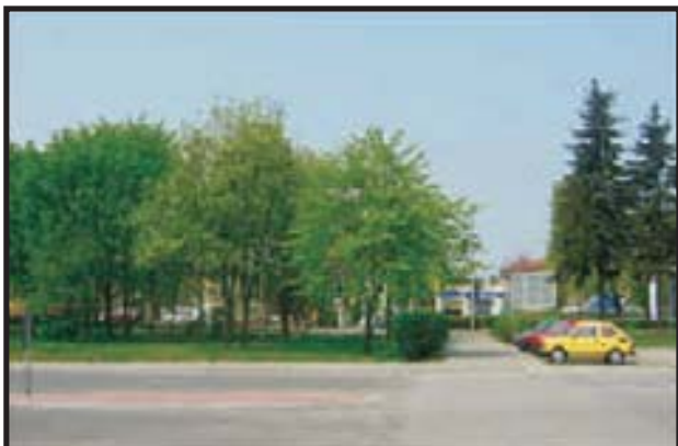
19. Wyremontowany chodnik i jezdnia na ulicy Szkolnej w Śremie - 2005r.
