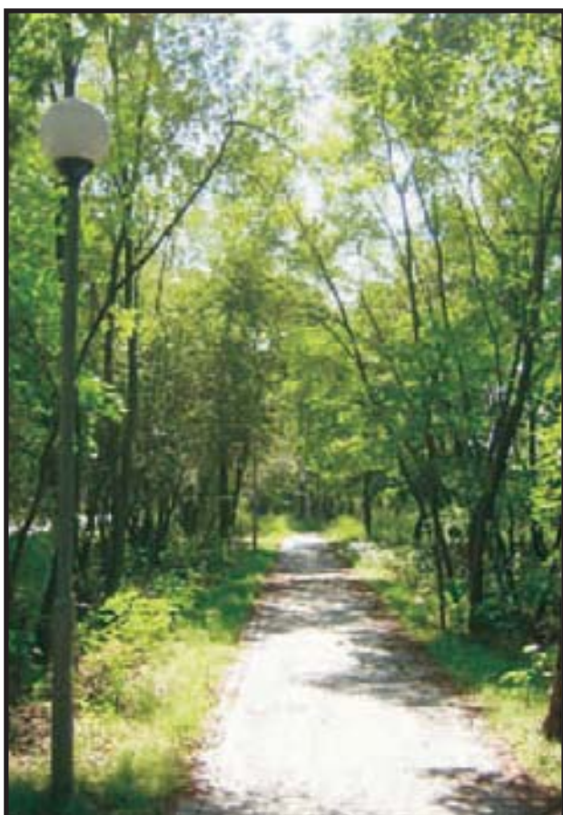
39. Alejka piesza z oświetleniem w Zbrudzewie wybudowana w 2006 r.
