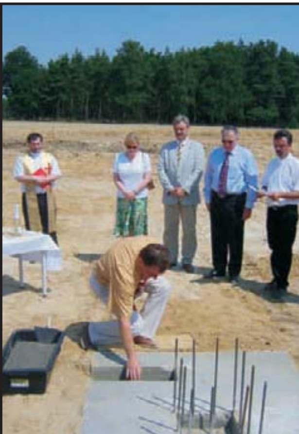
108. Wmurowanie kamienia węgielnego pod nową halę produkcyjną firmy WECO w Zbrudzewie - lipiec 2006 r.
