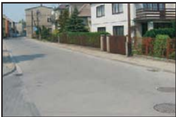
35. Przebudowana ulica Piaskowa i Podwale w Śremie - 2006 r.
