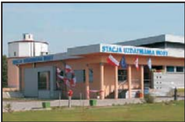
9. Nowa Stacja Uzdatniania Wody przy ul. Parkowej oddana do użytku w 2005r.
