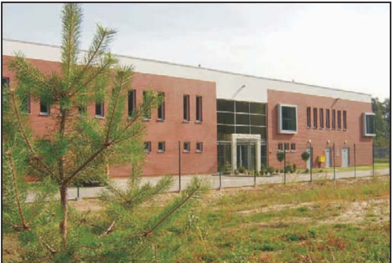
53. Nowa hala produkcyjno - magazynowa wraz z zapleczem administracyjno.-socjalnym firmy DUTRON w Psarskich przy ul. Klonowej - oddana do użytku w 2006 r.
