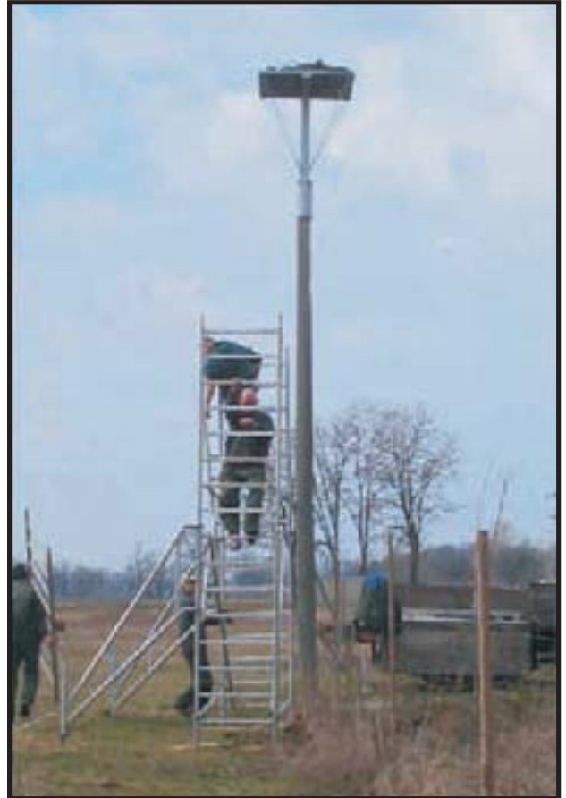
43. Montaż platformy pod gniazdo bocianie - 2004r.
