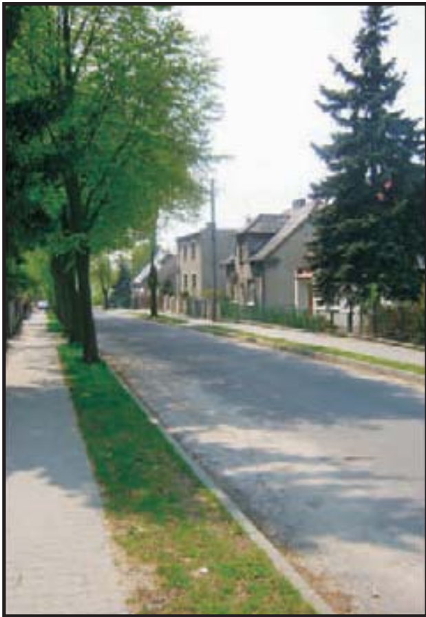
20. Przebudowane chodniki na ulicy Marciniaka w Śremie - 2004r.
