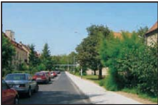
23. Przebudowana ulica Modrzewskiego w Śremie - sierpień - 2006r.
