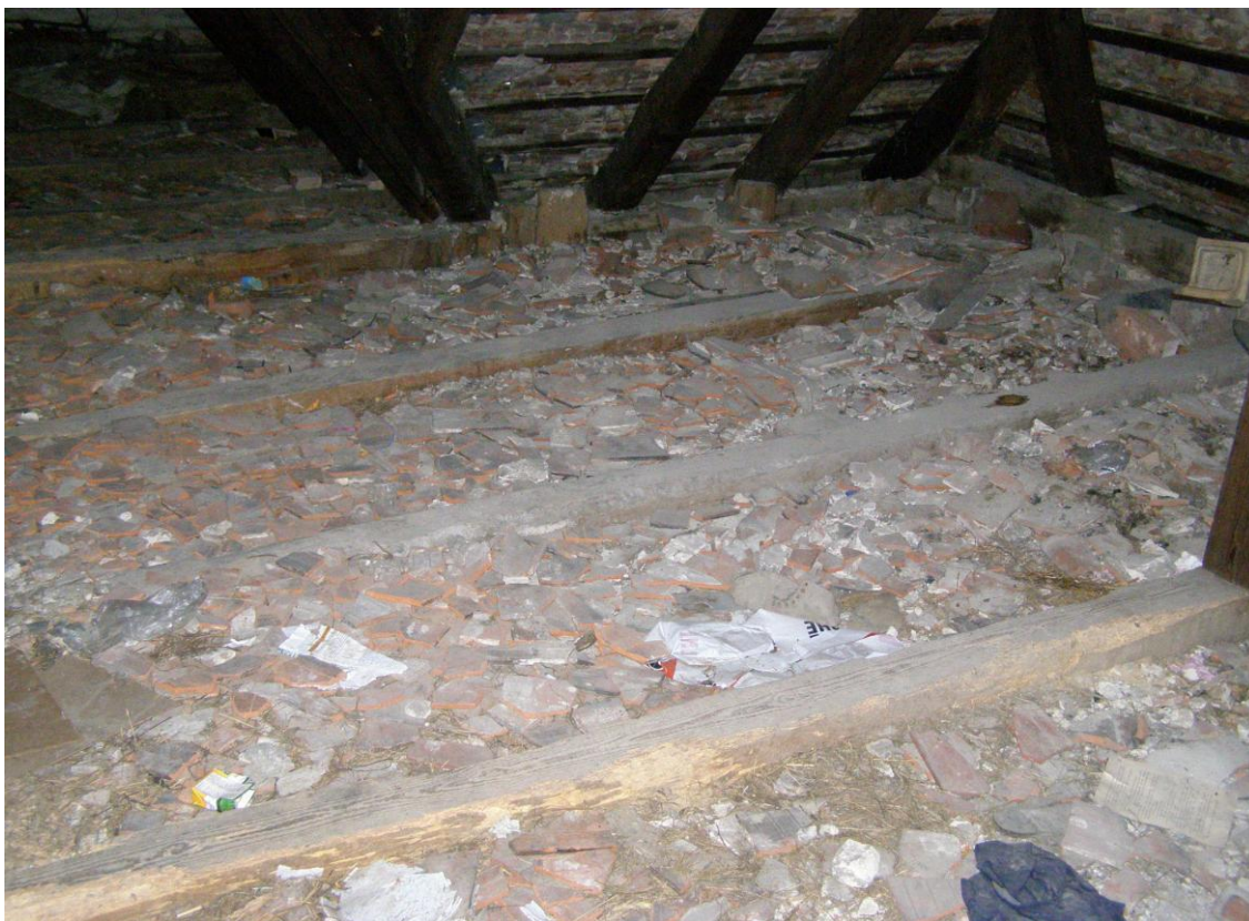
Zdjęcie nr 8. Widok stropu - wypełnienia powierzchni między belkami stropowymi połamaną dachówką.
