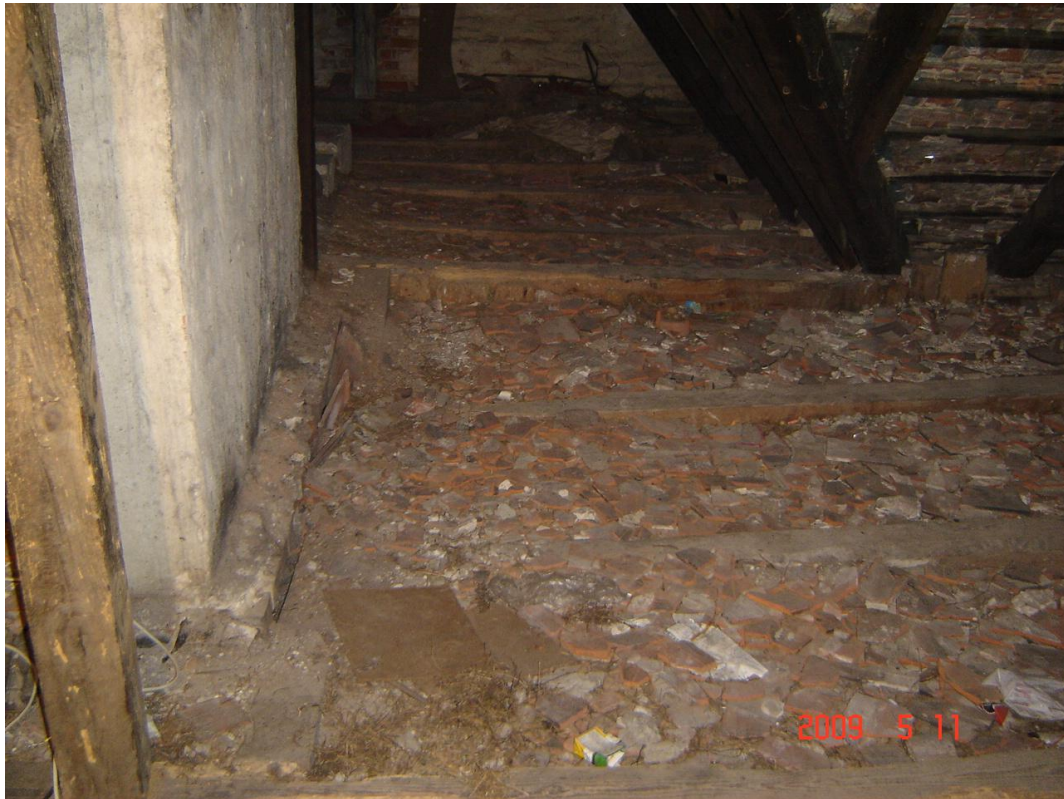
Zdjęcie nr 10. Widok stropu poddasza – zarwany strop
