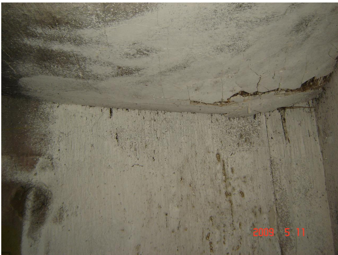
Zdjęcie nr 11. Widok zarwanego stropu poddasza od spodu
