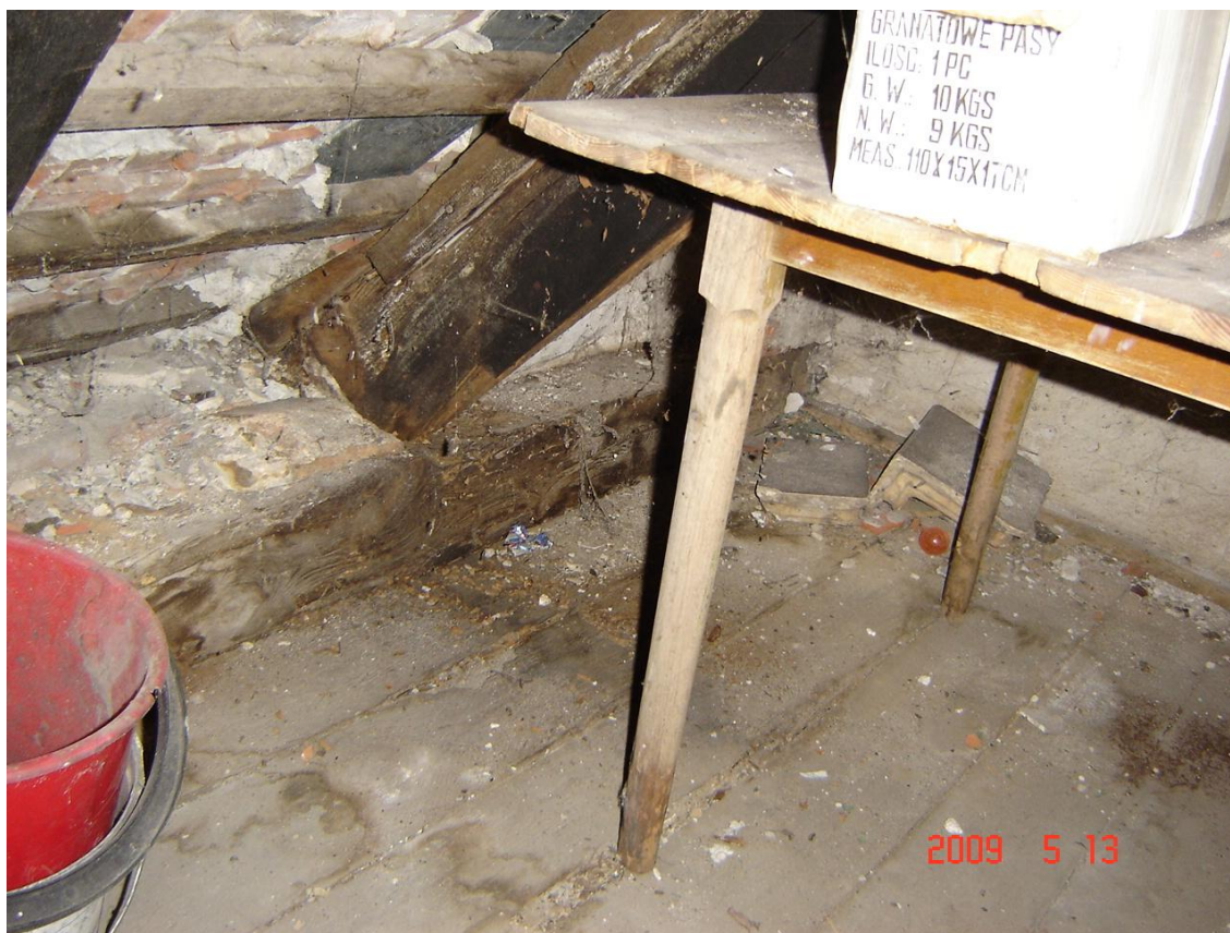
Zdjęcie nr 3. Widok połączenia murłaty z krokwią
