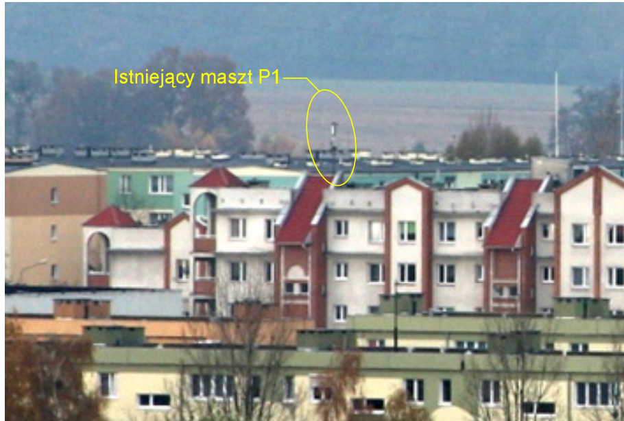
Widok z wieży wodnej - P1 (P1A)
