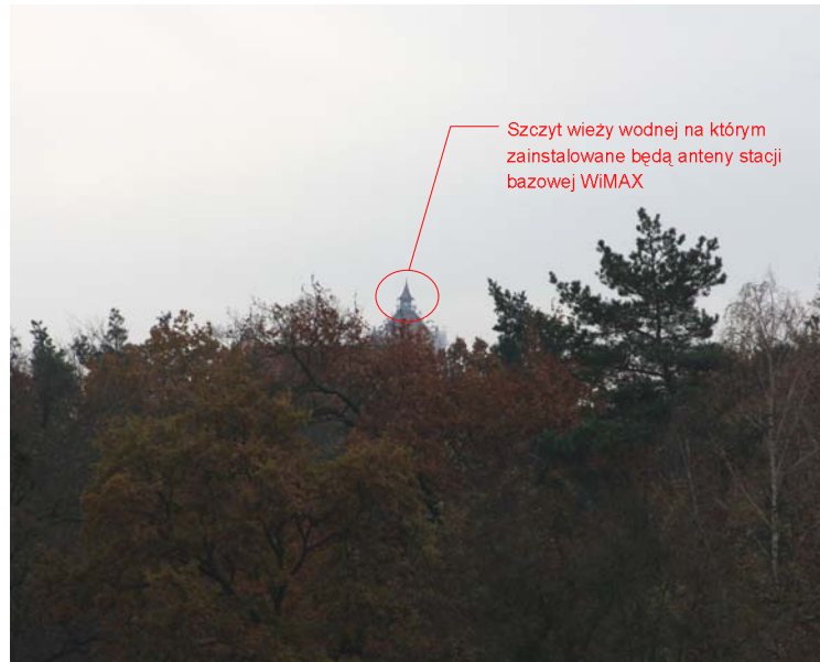
Widok w kierunku wieży wodnej – Terminal 18
