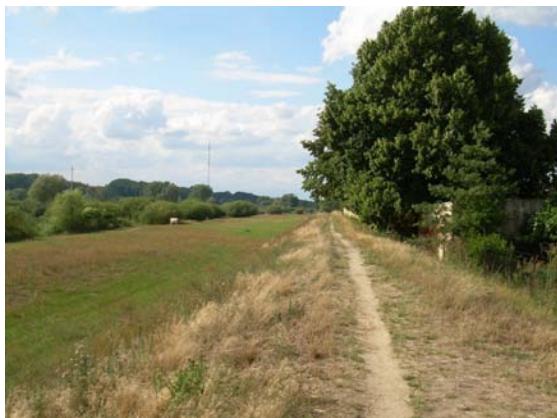
Fot. 1. Wał przeciwpowodziowy, widok w stronę północną z narożnika ul. Polnej
